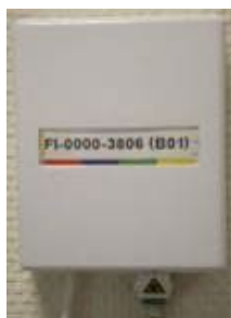
Figure 6 : FTTE passif PM - exemple de PTO
